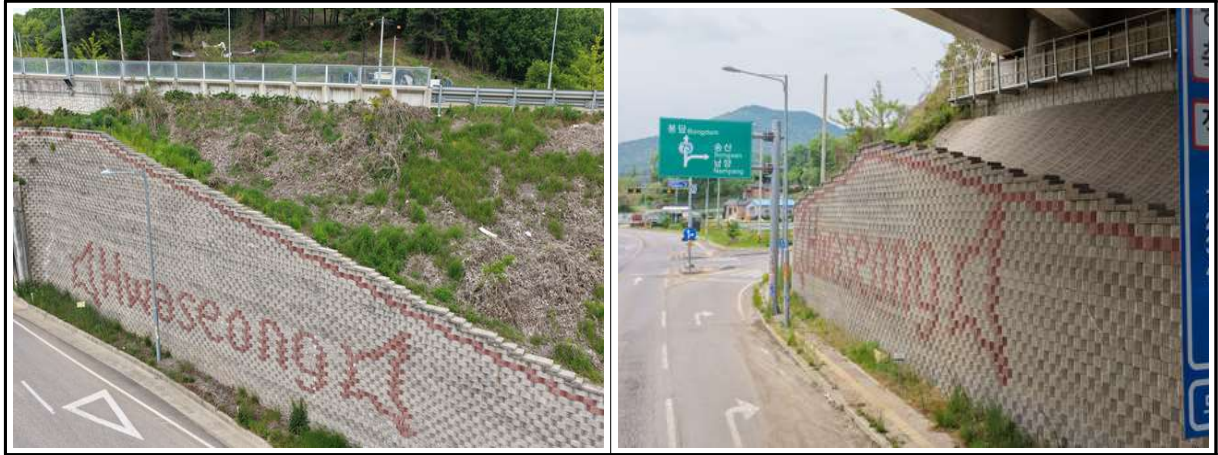
【사진 4.3.2】전면부 전경
