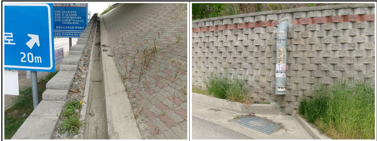
【사진 4.3.3】 배수시설 전경
