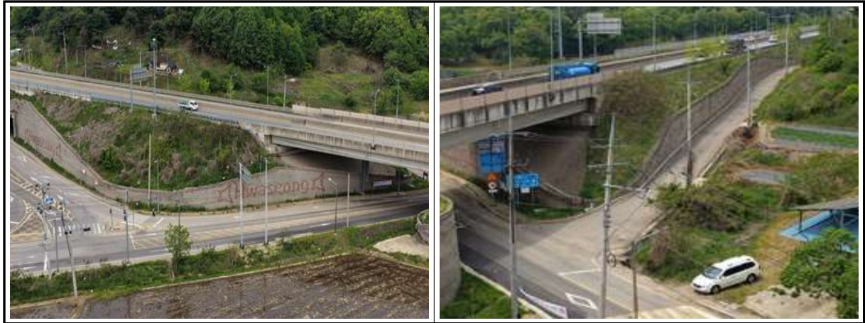
【사진 4.3.1】 지반, 기초부 전경
