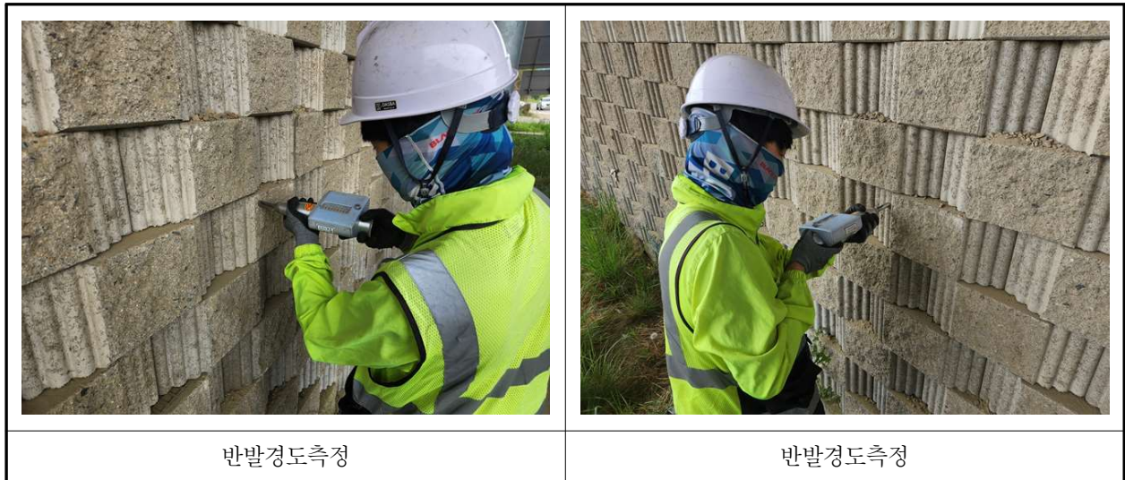
【사진 4.4.1】 재료시험 조사 전경
